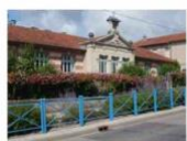
École du Pont des Arts à Sampigny
